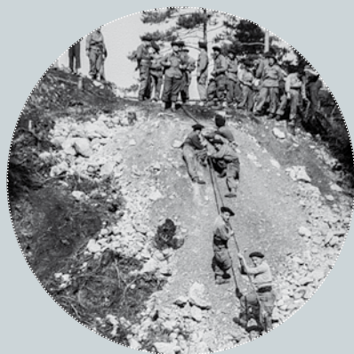
Französische Besatzungssoldaten bei der Errichtung des ersten Kaiserliftes am Aschenbrenner 1951.
